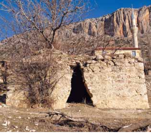
153 a- Güney Cephe
