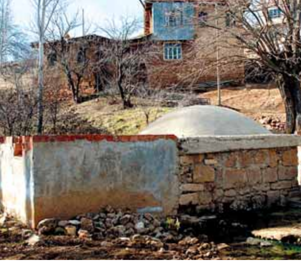
158 a- Kuzey Cephe
