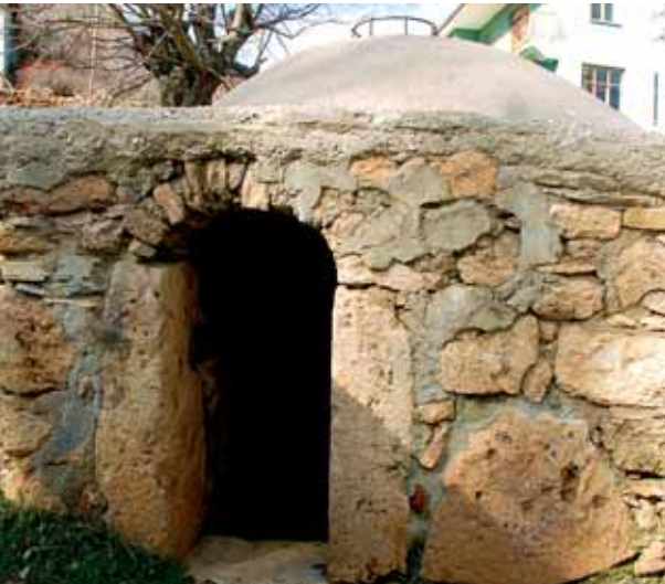
160 a- Batı Cephe, Doğu Bölüm
