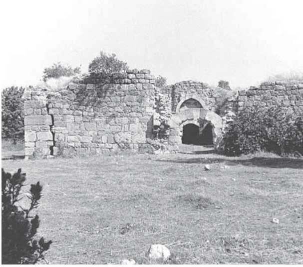
171 a- Güney Cephe
