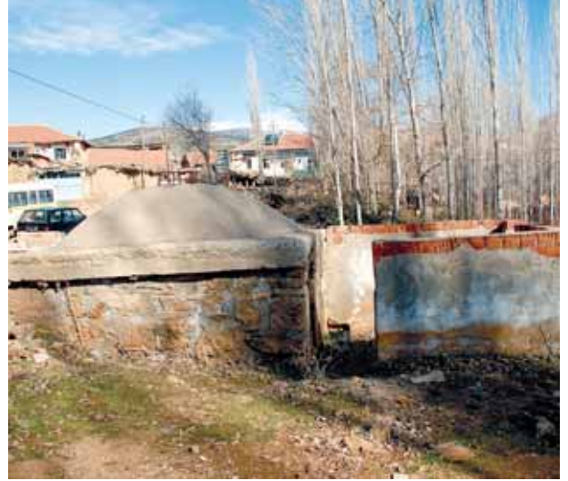
158 b- Güney Cephe
