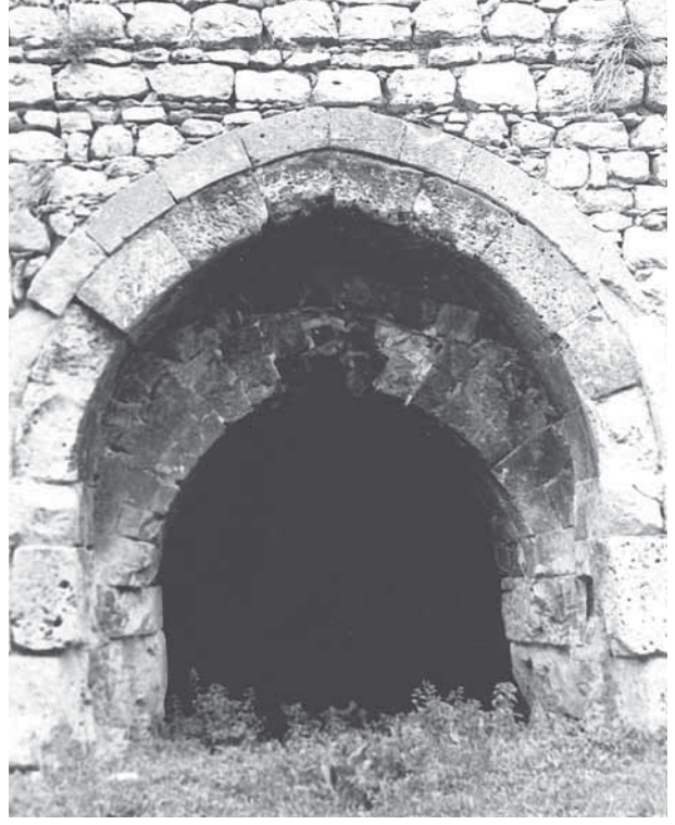
178 b- Avlu, Batı Revak, Güneyden İkinci Kemer
