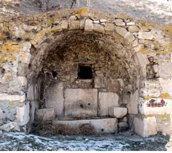
164 a- Batı Cephe
