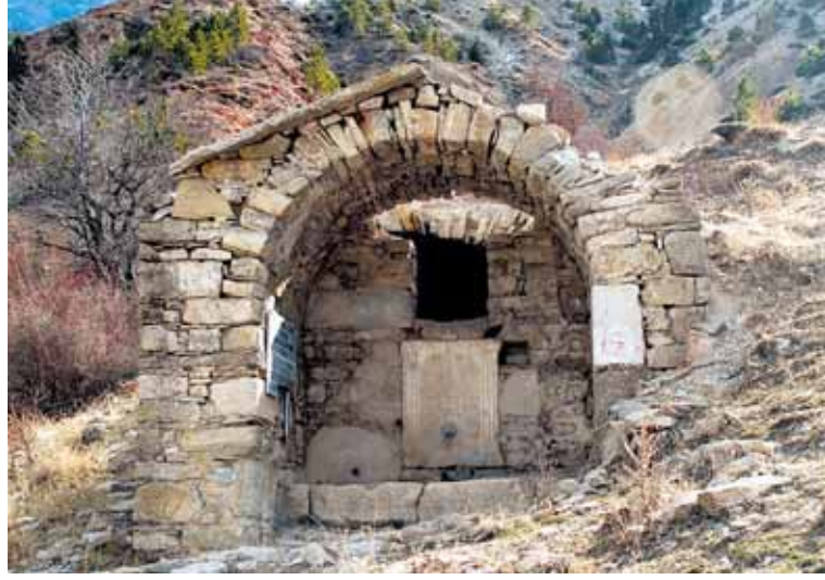
168 a- Kuzey Cephe
