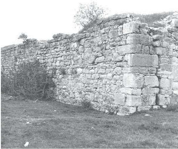
172 a- Batı Cephe
