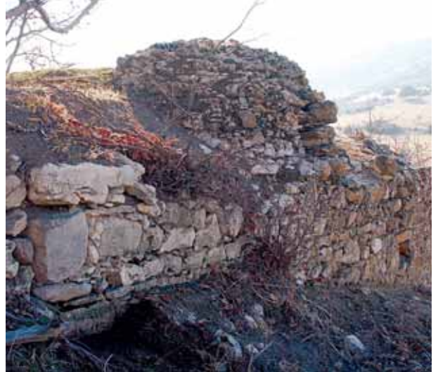
153 b- Batı Cephe
