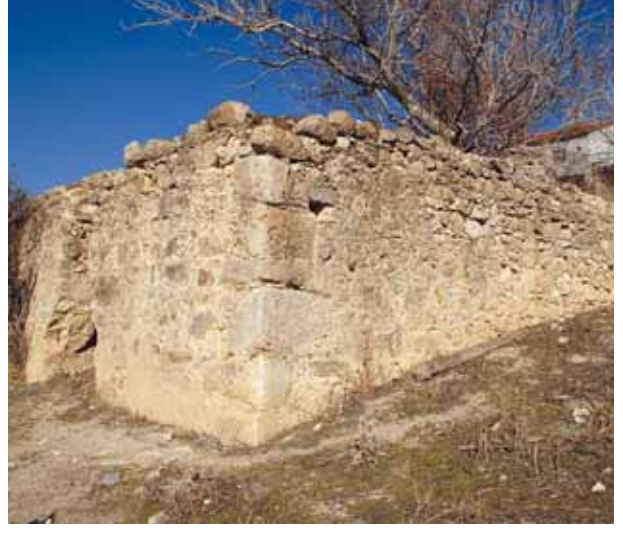
152 b- Güneydoğudan Görünüm
