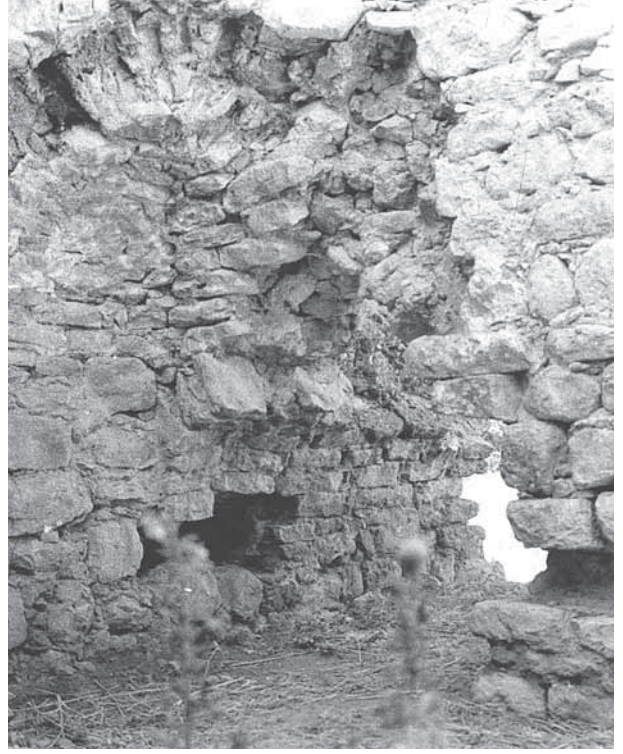
175 b- Avlu, Güneydoğu Köşe Mekanı, Güneybatıya Bakış
