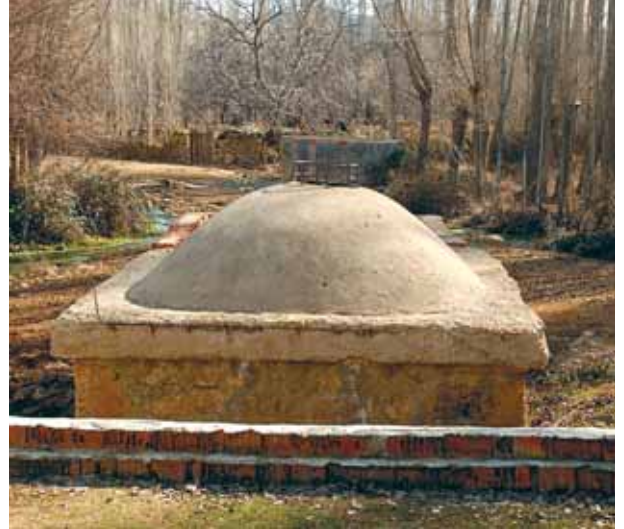
159 b- Batı Cephe
