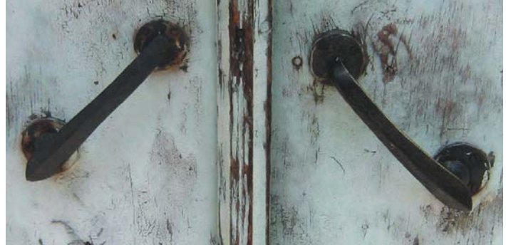
Levha-451: Karaağaç Mahallesi 1210/1 sokak no 4'de çapraz takılmış pirinç döküm tekniğinde yapılmış kapı kolları.
