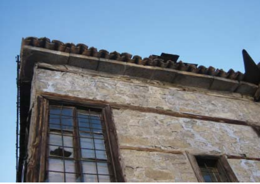
Levha-586: Kurtuluş Mahallesi 1421 Sokak'ta bulunan evin (Katalog 128) ince plaka halindeki saçakları.
