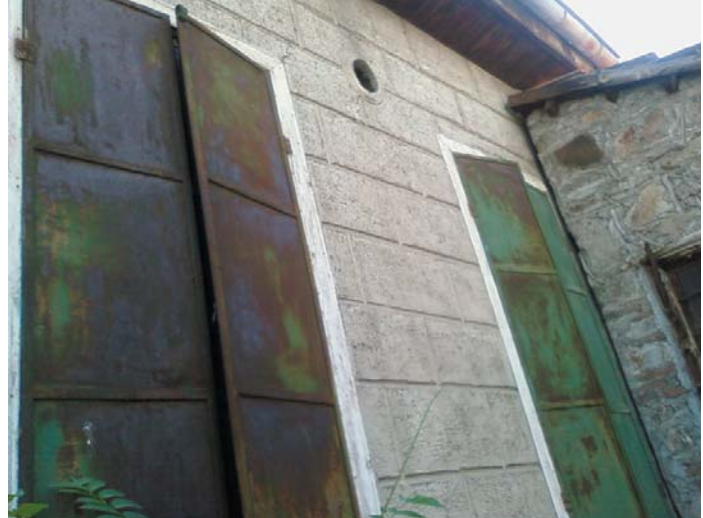
Levha-549: Hasan Çoban Evi'nin (Katalog 137) demir pencere kepenkleri.
