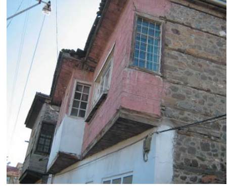
Levha-752: Kurtuluş Mah. 2308 Sokak 10 numarada bulunan evin cumbası ile hemen bitişigindeki evin gönyeli çıkması.
