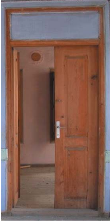
Levha-420: Çift kanatlı çift tablalı ve aydınlık pencereli oda kapısının ön görünümü (Vesile Atay Evi).
