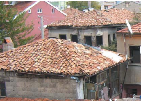
Levha-574: Çelebiler Mahallesi 1412 Sokak'ta bulunan evin (Katalog 22) dört yana eğimli kırma çatısı.
