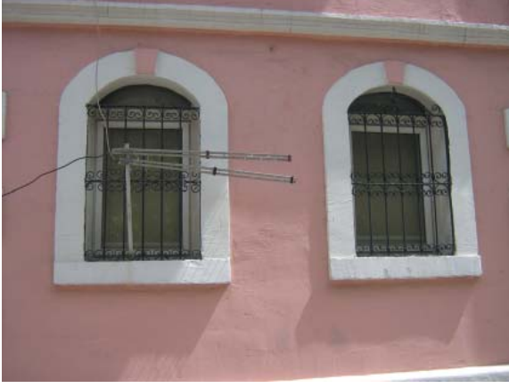
Levha-511: Kepeci Mahallesi 1215 Sokak'ta bulunan evin (Katalog 117) zemin katındaki tař sveli penceresi.
