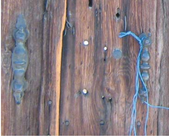
Levha-447: Turan Mahallesi 1308 Sokak 3 numarada bulunan evin silindirik formlu ve boğumlu kapı kolları.
