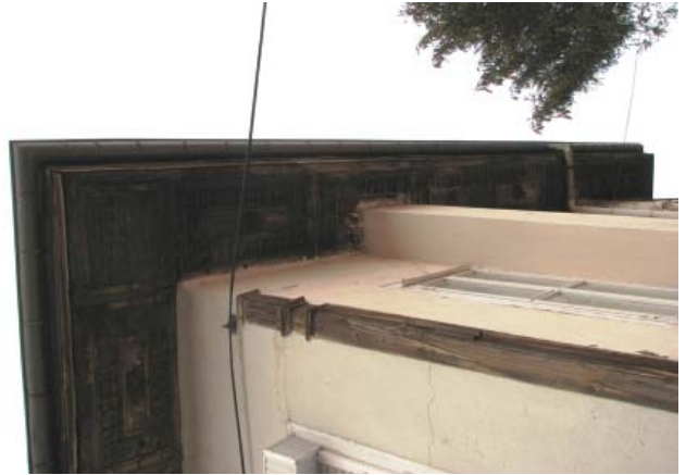
Levha-585: Şükrü Gülşen Evi'nin (Katalog 136) saçak uzun ve altları çitakari tekniğinde süslemelidir.
