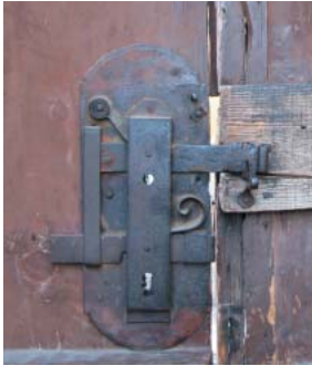
Levha-472: Gazi Kemal Mahallesi, 1307-1308 Sokak, No 16'daki evin (Katalog 69) kapı kilit mekanizması.
