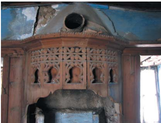
Levha-639: Hendenlerin Evi'nin (Katalog 106) üst katındaki ahşap davlumbazlı ocak.
