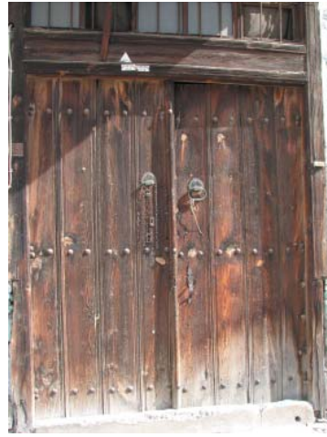
Levha-412: Tablaları arasında binileri olan bir dış kapı örneği. İskender Mah., İnce Sokak, 65 numarada bulunan evin cümle kapısı.
