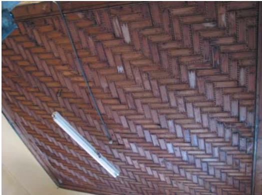
Levha-684: Eğirdir İlçesi 285 ada, 4 parselde bulunan evin tavanı.
