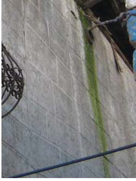
Levha-750: Turan Mahallesi Hallaç Sokađı 10 numarada bulunan evin kuzey cephesi.
