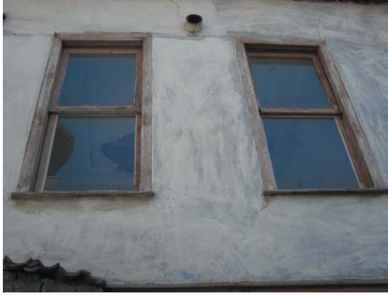
Levha-488: Çelebiler Mahallesi, Damgacı Sokak, No 1'de bulunan evin üst kat pencereleri.
