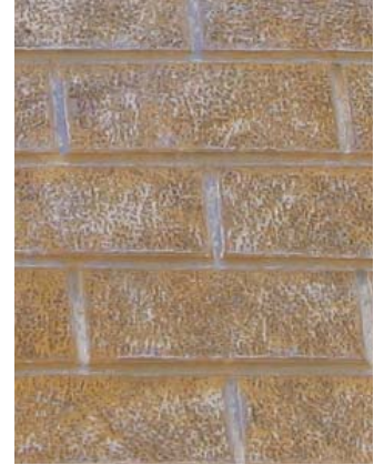
Levha-749: Keçeci Mahallesi 2301 Sokak'ta bulunan evin (Katalog 108) ön cephesinde sıva üzerine yapılan süsleme.
