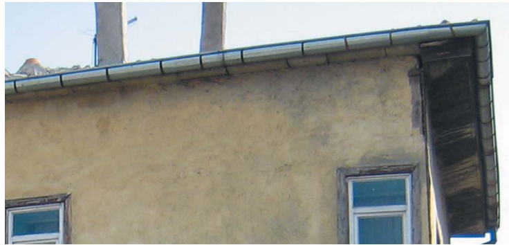
Levha-589: Sermet Mahallesi'nde bulunan evin (Katalog 130) teneke oluklarla çevrilmiş saçakları.
