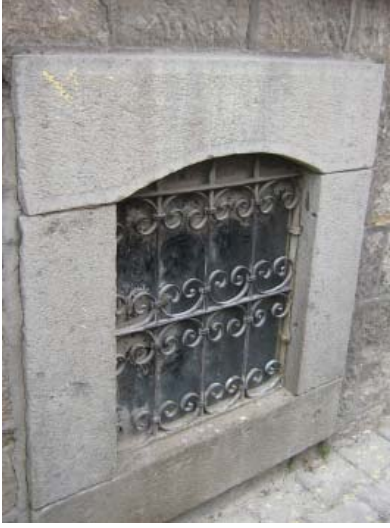
Levha- 477: Şaban Karadağ Evi'nin (Katalog 4) bodrum katında bulunan taş söveli penceresi.
