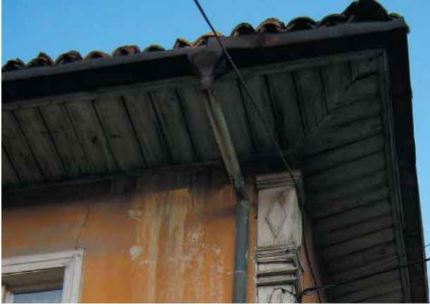
Levha-582: Çelebiler Mahallesi, 1401 sokak, 9 nolu ev düz ve kısa olan ahşap saçaklara sahiptir.
