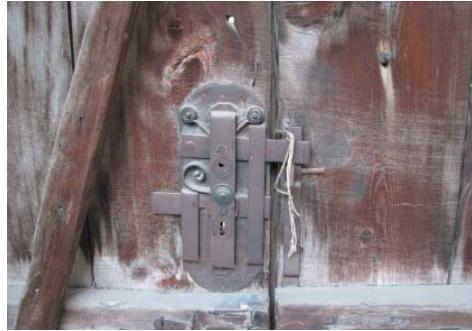
Levha-473: Hamidođlu Hüseyin Ađa Evi'nin (Katalog 141) cümle kapısı kilit mekanizması.
