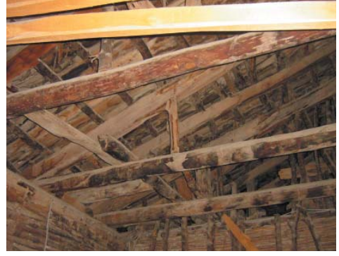
Levha-578: Mehmet Ali Yaltırak Evi'nin ahşap çatı sisteminin kurulumu.
