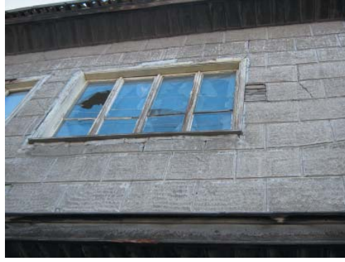
Levha-751: Kurtuluş Mahallesi 2308 Sokak 10 numarada bulunan evin cumba cephesi.
