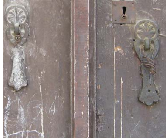
Levha-443: Doğanlı Mahallesi'nde bulunan evin (Katalog 34) kapı tokmakları.
