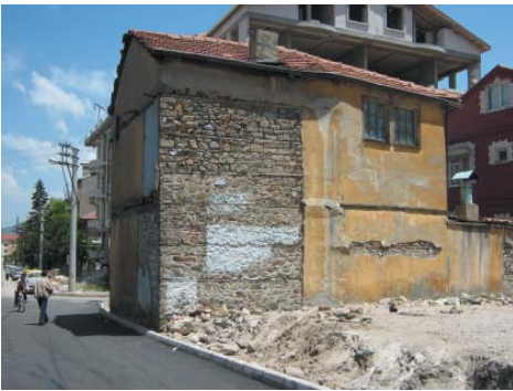
Levha-588: Kepeci Mahallesi, 1219 Sokak'taki evin (Katalog 114) saçağı.
