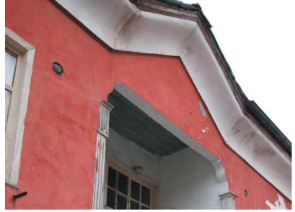
Levha-583: Kurtuluş Mahallesi Cevizli Sokak'ta bulunan ev (Katalog 127) ön cephede içbükey saçaklara sahiptir.
