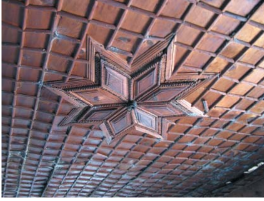
Levha-681: Eğirdir Hamam Mahallesi 36. Sokak'ta bulunan evde üst katta oda tavanı.
