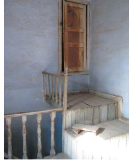
Levha-572: Müşerref Büyüksilleli Evi'nde (Katalog 99) merdiven ve üç basamakla çıkılan ahşap gömme dolap.
