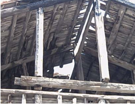
Levha-576: Hüseyin Baykara Evi'nin (Katalog 11) ahşap çatı sistemi. İçeriden görünüm.
