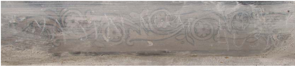
Levha- 727: Keçeci Mahallesi 2301 Sokak'taki evin (Katalog 108) kuzeye bakan cephe duvarındaki süsleme kuşağı. Üzeri beyaz boya ile kapatılmıştır.
