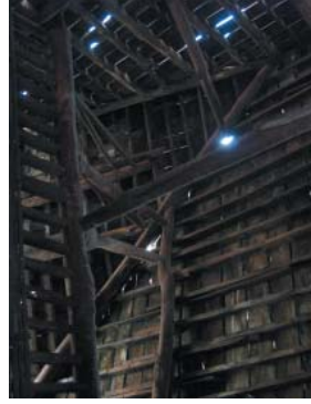
Levha-577: Fethi Gülyavaş Evi'nin (Katalog 140) ahşap çatı sistemi. İçeriden görünüm.
