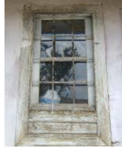
Levha-496: İskender Mahallesi İnce Sokak'taki evin (Katalog 95) zemin kat penceresi.
