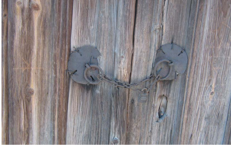
Levha-464: İskender Mahallesi İnce Sokak no: 10'da bulunan evin kapı çekecekleri.
