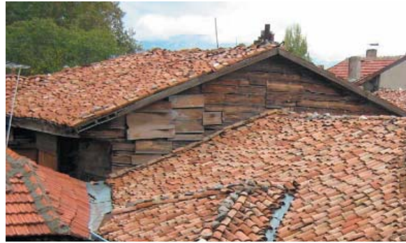
Levha-575: Ethem Pehlivan Evi'nin (Katalog 21) iki yana eğimli kırma çatısı. Yukarıdan görünüm.
