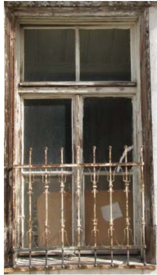
Levha-499: İskender Mahallesi İnce Sokak'ta bulunan evin (Katalog 94) zemin kat penceresi.
