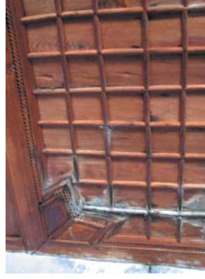
Levha-682: Eğirdir Hamam Mahallesi 36. Sokak'ta bulunan evde üst katta oda tavan detayı.
