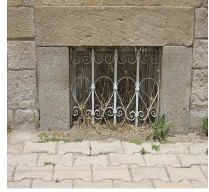
Levha- 479: H. Hüseyin Toka Evi'nin (Katalog 134) bodrum katında bulunan taş söveli penceresi.
