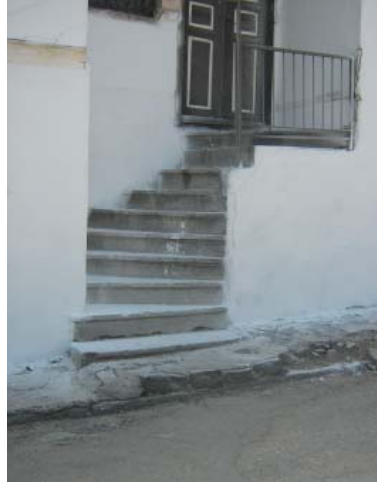
Levha-553: Zehra Gümüş ve Zehra Ülker Evi'nde (Katalog 44) merdiven yandan verilmiştir.
