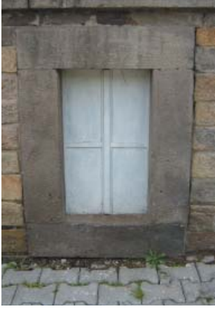
Levha-517: Fethi Gülyağcı Evi'nin (Katalog 140) bodrum katındaki taş söveli pencereleri.
