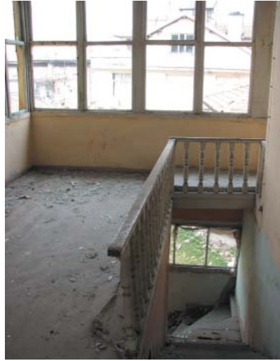
Levha-559: Eřref Karcan Evi'nde (Katalog 123) st kata ıkan kırma merdiveni.
