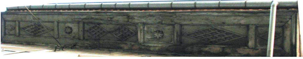
Levha-617: Kepeci Mahallesi, 1215 Sokak'taki evin (Katalog 117) ahşap saçak altı süslemeleri.
