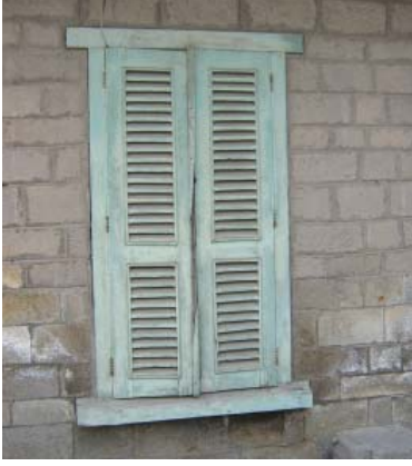
Levha-542: Dudu-Meral Toka Evi'nin (Katalog 133) zemin kat pencerelerine ait ahşap kepenkler.
