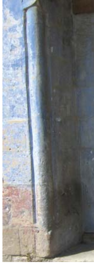
Levha-696: Sermet Mahallesi 1208 Sokak'taki evin (Katalog 129) plastırı.
