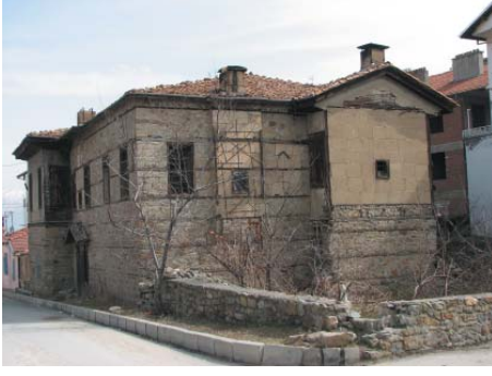
Levha-579: Sarıtepeilerin Evi'nin (Katalog 38) bacaları ve duvardaki bu bölümü düzgün kesme köfke taştan yapılmıştır.
