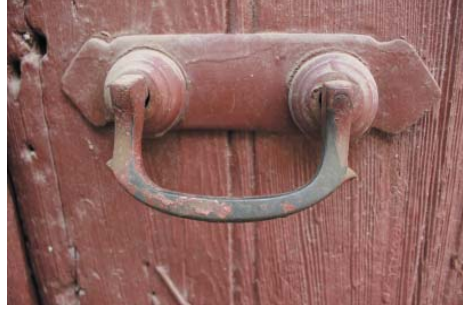
Levha-455: Şükrü Dulupçu Evi'nde (Katalog 63) diğer cümle kapısındaki kapı kolu.
