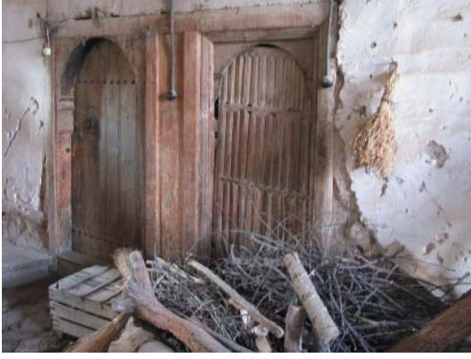
Levha-428: Afşar Köyü'ndeki 54 pafta 147 numaralı evin zemin katındaki kapılar.
