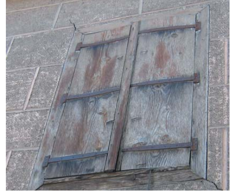
Levha-547: Turan Mahallesi 1218 Sokak 3 numarada bulunan evin ahşap pencere kepenkleri.
