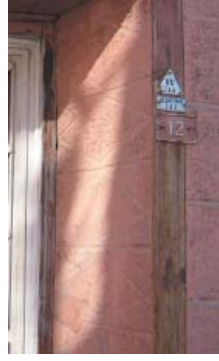
Levha-745: Turan Mahallesi Hallaç Sokağı 12 numarada bulunan evin giriş sahanlığı.
