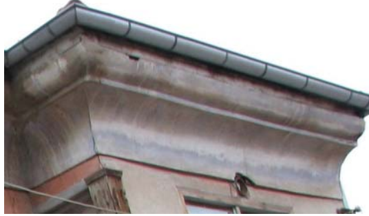
Levha-587: Turan Mahallesi 2101 Sokak'ta bulunan evin (Katalog 135) altta içbükey, üstte dışbükey saçakları.
