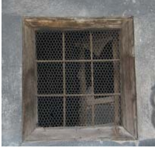
Levha-494: Çelebiler Mahallesi 1412 Sokak'ta bulunan evin (Katalog 22) zemin kat pencereleri.
