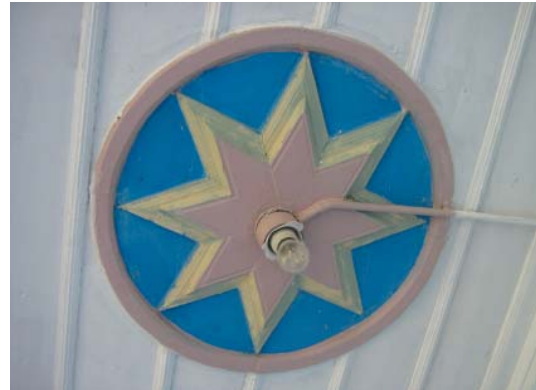
Levha-685: Uluborlu İlçesi, Zincirli Mahallesi 186 ada 2 parseldeki evin tavan göbeği.
