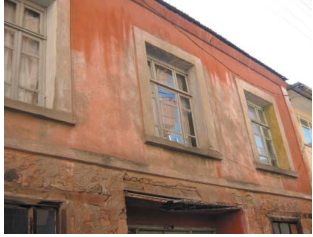
Levha-516: Kurtuluş Mahallesi Önder Sokak 7 numarada bulunan evin üst katındaki pencere söveleri.
