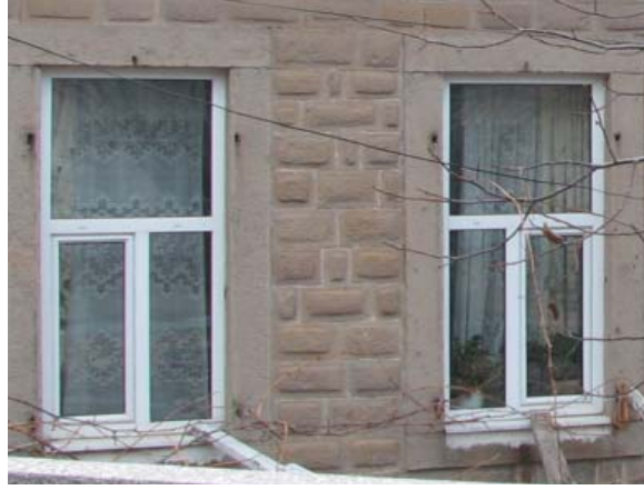
Levha-518: Hasan Çoban Evi'nin (Katalog 137) zemin katındaki düz taş söveli pencereleri.
