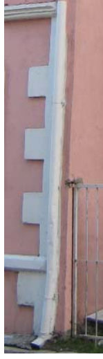
Levha-687: Kepeci Mahallesi 1215 Sokak'ta evin (Katalog 117) taş köşebendi.
