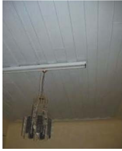
Levha-389: Çelebiler Mahallesi, 1411 Sokak'taki evde (Katalog 16) ahşap tavan.
