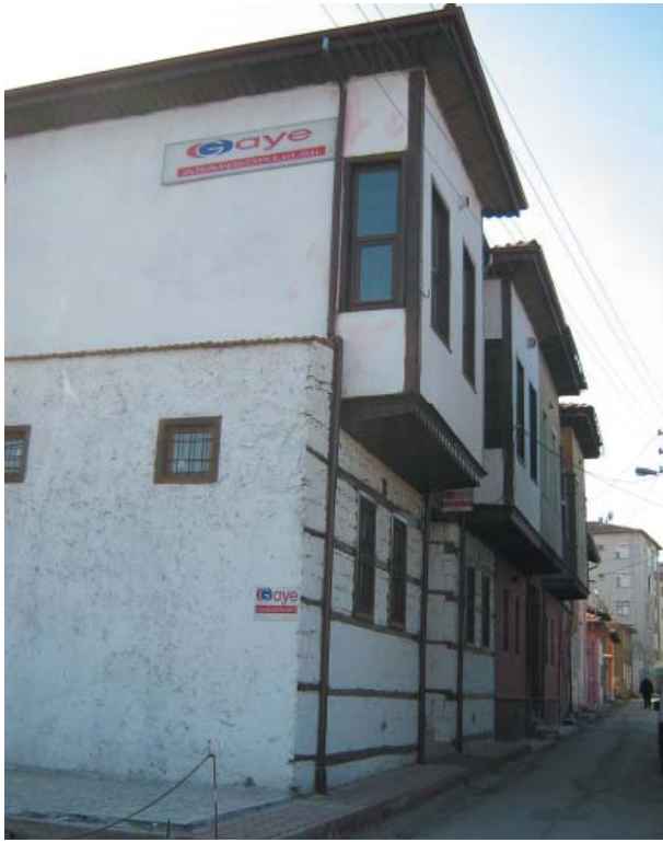
Levha-121: Nuri Karataş Evi'nin (Katalog 79) yola bakan cephesi.
