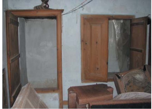
Levha-359: Süleyman Güngör Evi’nde (Katalog 68) yüklük kullanımı.
