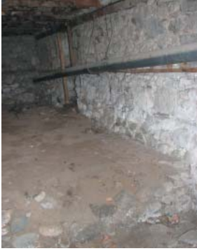
Levha-251: Kurtuluş Mahallesi, Çayboyu Çınar Caddesi'ndeki (Katalog 124) evin bodrum katı.
