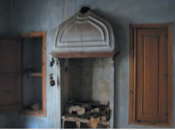
Levha-339: Süleyman Güngör Evi’nin (Katalog 68) alçı davlumbazının her iki yanında ahşap dolaplar yer almaktadır.
