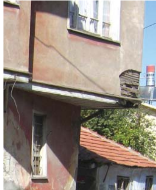
Levha-179: Gazi Kemal Mahallesi, 1308-1310 sokak, No 70'de bulunan evin köşe çıkması.
