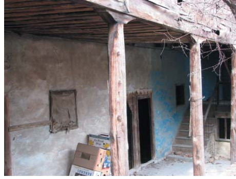
Levha-237: Çelebiler Mahallesi, 1401 Sokak'ta bulunan evin (Katalog 26) taşlığı.
