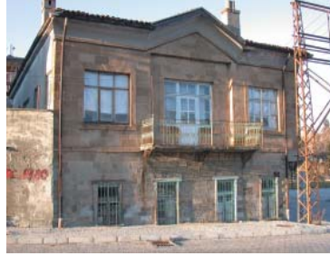
Levha-148: Dudu-Meral Toka Evi'nin (Katalog 133) güney cephesi.
