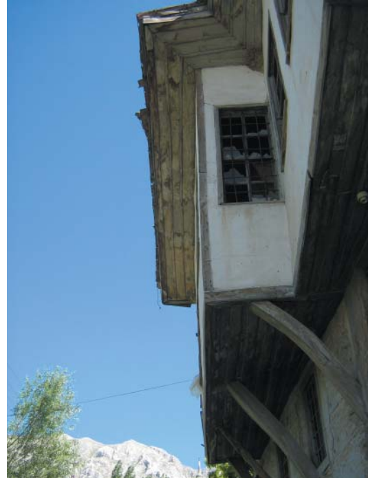
Levha-195: Uluborlu'da Zincirli Mahallesi, 203 ada, 6,7,9 parsellerde bulunan evin cumbasının görünümü.
