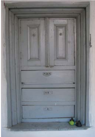
Levha- 355: Eğirdir İlçesi Seydim Mahallesi'nde bulunan evin ahşap gömme dolabının altı üç çekmecesidir.
