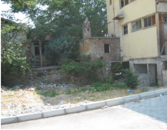
Levha-306: Eşref Karcan Evi'nin (Katalog 123) bahçesindeki müştemilat yapısı.
