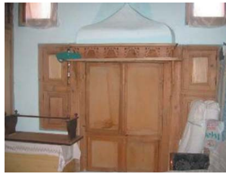
Levha-335: Doğancı Mahallesi 1210 Sokak'ta bulunan evin (Katalog 32) üst katındaki ocak davlumbaz.
