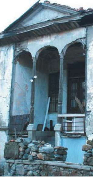
Levha-110: Doğançı Mahallesi 2312 Sokakta bulunan evin (Katalog 30) girişi.-cepheden-
