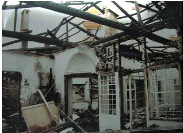
Levha-286: Kınık Evi'nin (Katalog 91) üst katında pahlı oda duvarı.
