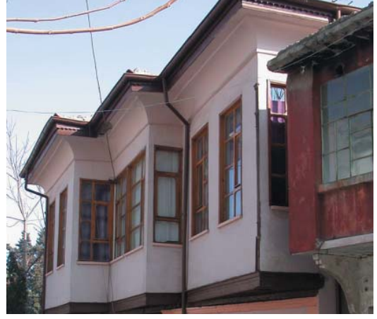
Levha-174: Nimet Yazgan Evi (Katalog 9) üç gönyeli çıkmalıdır.
