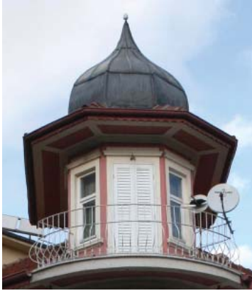
Levha-144: Hüseyin Töngce Evi'nin (Katalog 64) çatısındaki kubbesi.
