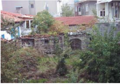
Levha-233: Saritepe Evi'nin (Katalog 38) bahçesindeki yıkılmış mekanlar.
