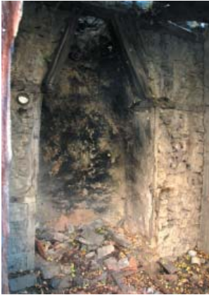
Levha-312: Müşerref Büyüksilleli Evi'nde (Katalog 99) bahçesindeki müştemilat yapısı içerisindeki büyük ocak.
