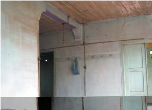
Levha-289: Celal Bey Evi'nde (Katalog 37) üst kat sofasındaki Bursa kemeri.
