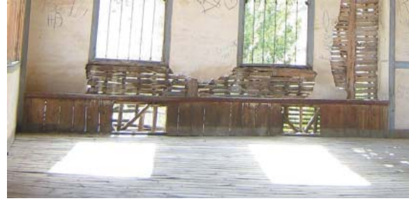
Levha-379: Demirci Mehmet Efe Karargah Konağı'nın kuzey yöne bakan cumbasında makatlık kullanımı görülmektedir.
