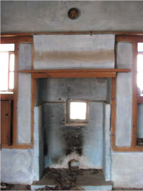
Levha-326: Doğanca Mahallesi, 2416 Sokak'ta bulunan evin (Katalog 33) ikinci katındaki ocağın davlumbazı
