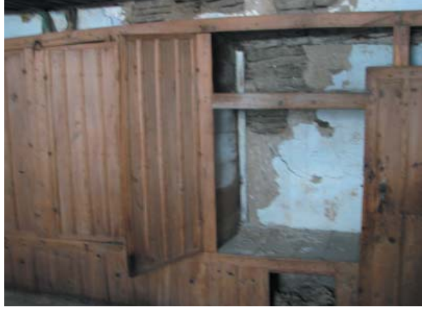
Levha-338: Doğancı Mahallesi, 2416 Sokak’taki evde (Katalog 33) bulunan gömme dolapların üzeri korkulukla çevrilmemiştir.
