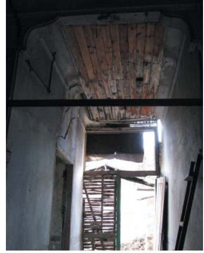
Levha-293: Çetin Atman ve Sadık Öncü Evi'nde (Katalog 139) Bursa kemeri.
