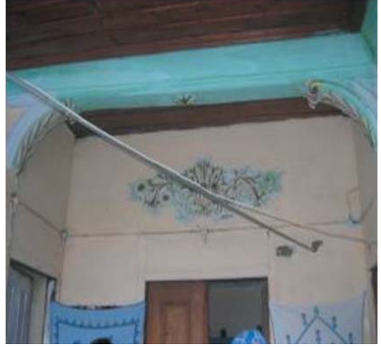
Levha-288: Doğanlı Mahallesi 2416 Sokak'taki evin (Katalog 34) sofasındaki volütlü kemer.
