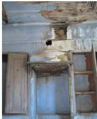
Levha-383: Müşerref Büyüksilleli Evi'nde dolapların üst sınırı aynı zamanda ocak külahının alt sınırı olmaktadır.
