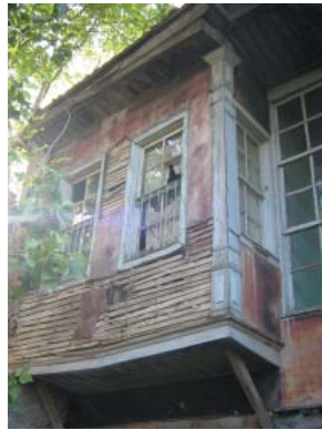
Levha-155: Niyazi Anlı Haliloğlu Evi’nin (Katalog 101) arka cephesindeki cumba.
