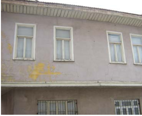
Levha-191: Kepeci Mahallesi, 1219 Sokak ev (Katalog 118) ıkmasında dört pencereye sahiptir. Pencereler ikiřerli düzende yer almıřtır.
