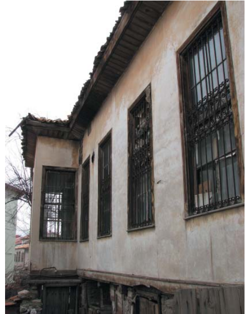
Levha-118: Doğanca Mahallesi 2312 Sokak'ta bulunan evin (Katalog 30) kuzey cephesi.
