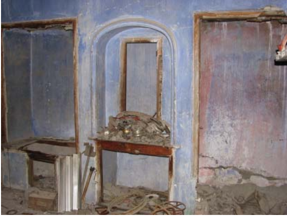
Levha-362: Sadık Öncü ve Çetin Atman Evi'nde (Katalog 139) yer alan basık kemerli çiçeklik.
