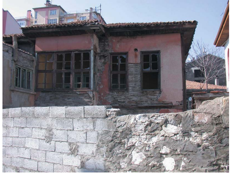
Levha-124: Nimet Yazgan Evi'nin arka cephesi
