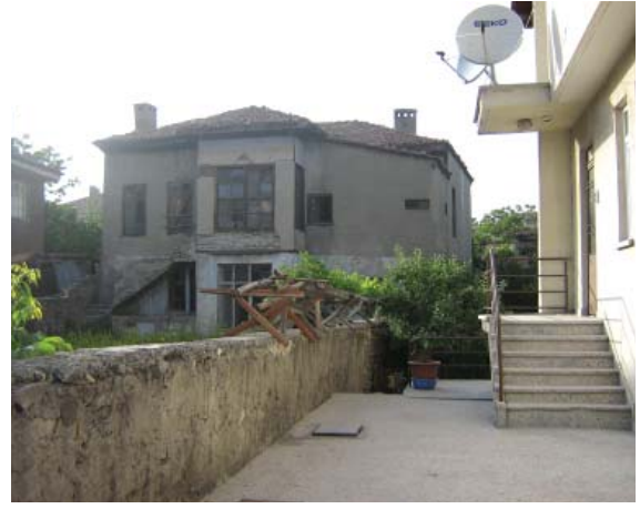
Levha-120: Çelebiler Mahallesi, 1414-1451 Sokak'taki evin arka cephesi.
