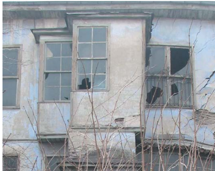
Levha-325: Kurtuluş Mahallesi, Çayboyu Çınar Cadde'de bulunan evde (Katalog 124) tuvalet yapısı doğru taşkınlık yapmaktadır.
