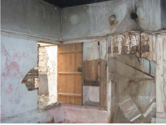
Levha-380: Demiralay Konağı Misafirhanesi'nde (Katalog 24) üst katında davlumbaz ile rafın görünümü. Raflar, davlumbazın külahının başladığı alt çizgi hizasındadır.
