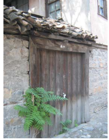
Levha-405: İskender Mahallesi, 1308 (İnce) Sokak'ta bulunan evin (Katalog 96) ahşap bahçe kapısı.
