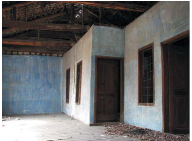
Levha-274: Doğancı Mahallesi, 2416 Sokak'ta bulunan evin hanayın batı bölümü.
