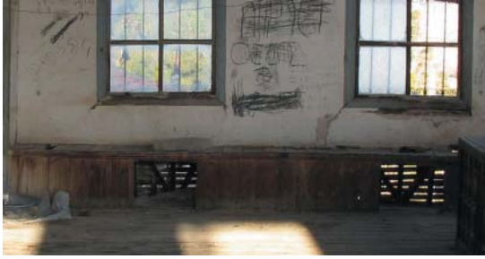
Levha-378: Demirci Mehmet Efe Karargah Konağı'nın güney yöne bakan sofasında makatlık kullanımı görülmektedir.
